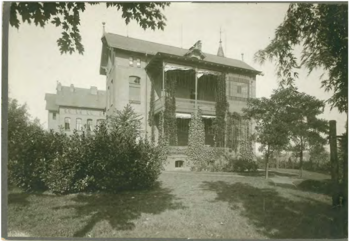
Städt. Krankenhaus Bielefeld Haus 1, 1899, Seitenansicht
