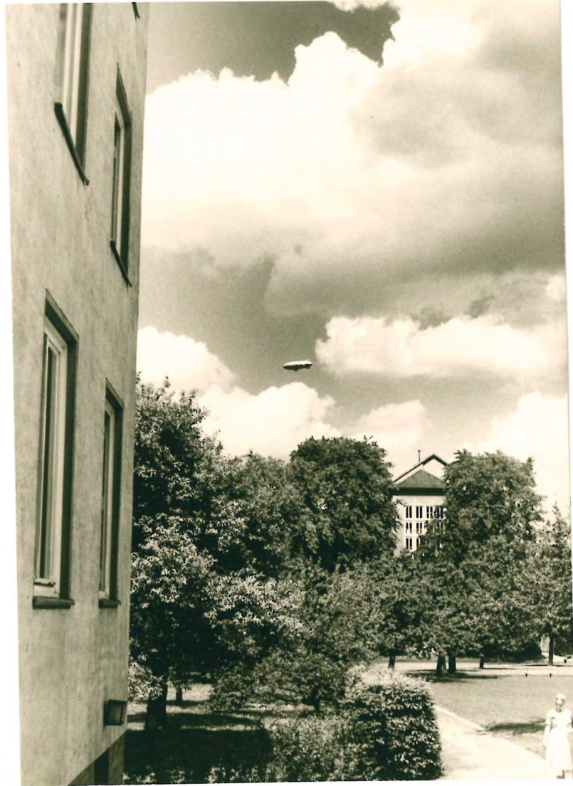
Blick vom Eingang des Schwesternhauses durch das Krankenhausgelände Richtung Haus 8
