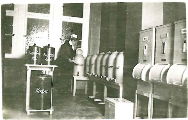
Vorratsraum der Küche
