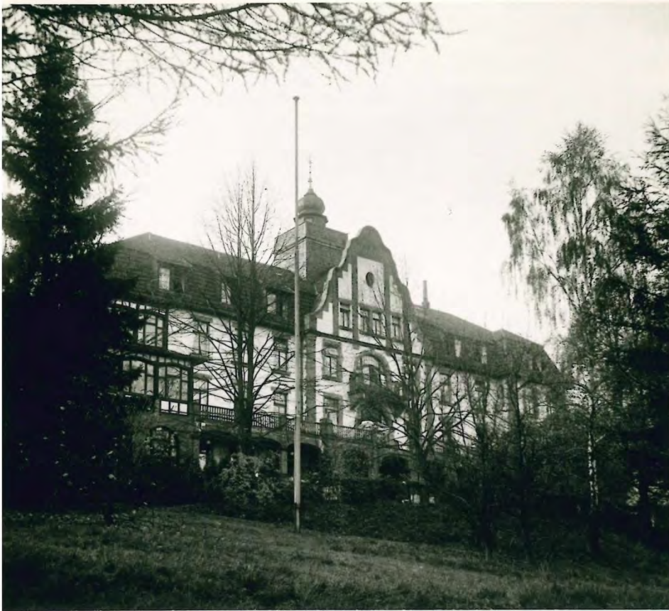
Städt. Krankenhaus Bielefeld Teutoburgerwald-Sanatorium
